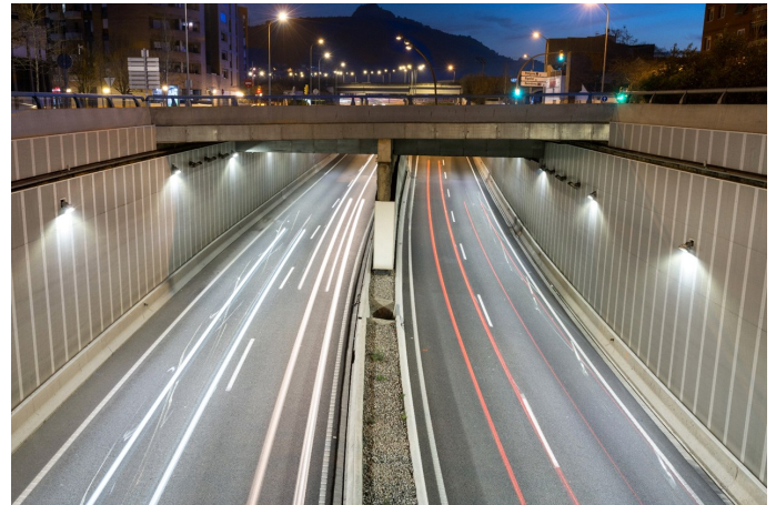
C-17 Tunnel Montcada y Reixac, Barcelona - Spain
